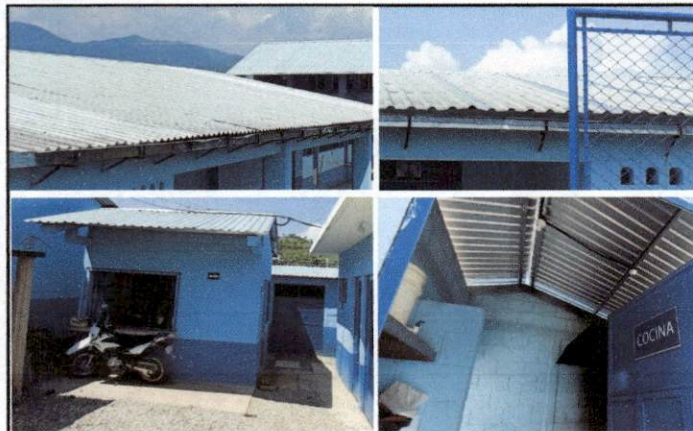
Foto 1: Techo de módulos de aulas reparado; techo de lavadero y cocina instalado.
