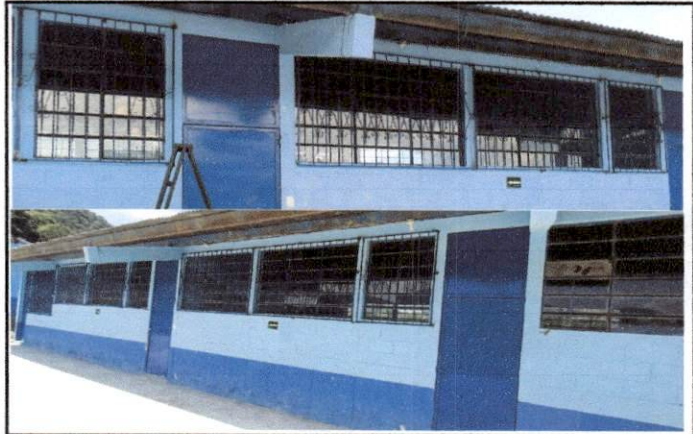
Foto 2: Balcones instalados satisfactoriamente.
