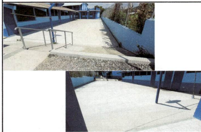
Foto 3: Losa del patio deportivo instalado.
