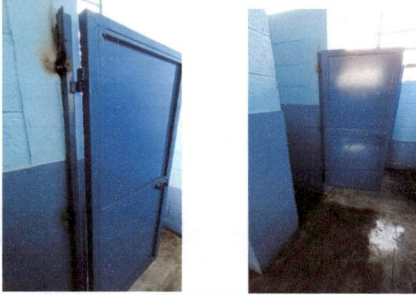
Foto 1: Puerta de sanitario instalado satisfactoriamente.
